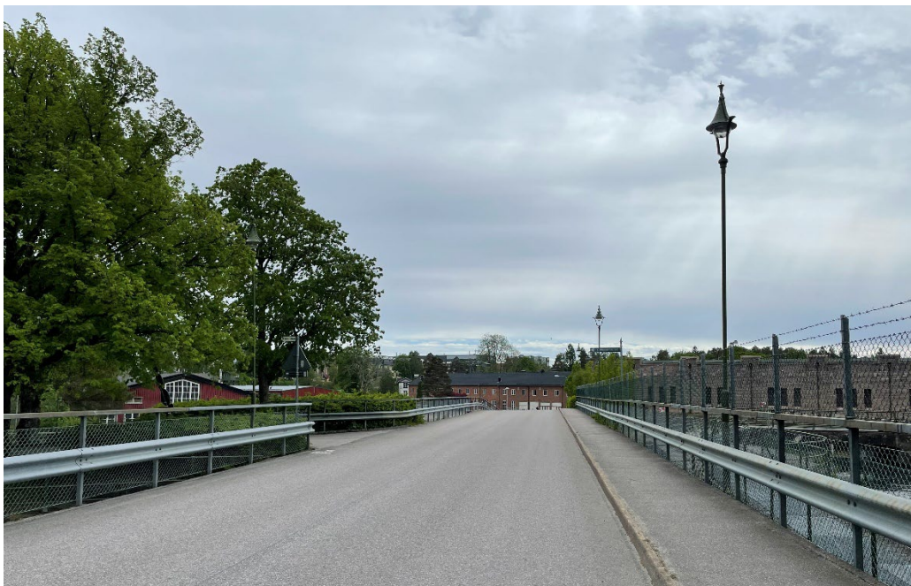
Bild 4. Sträcka av Åkersbergsvägen som innefattar broar över kraftkanalerna vid intaget till Olidans kraftverk.
