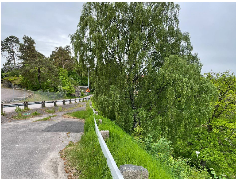
Bild 10. Slänt och asfaltsyta invid Åkersbergsvägen där stabilitetshöjande åtgärder ska genomföras i samband med ledningsomläggningar och iordningsställande av vägen.
