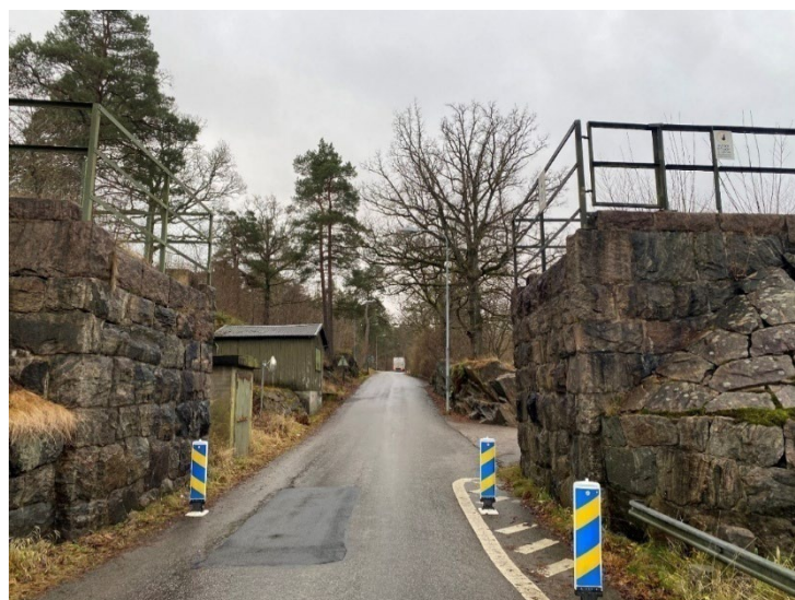
Bild 27. Bockkranens fundament som tidigare utgjorde en järnvägsbro över Åkersbergsvägen.
