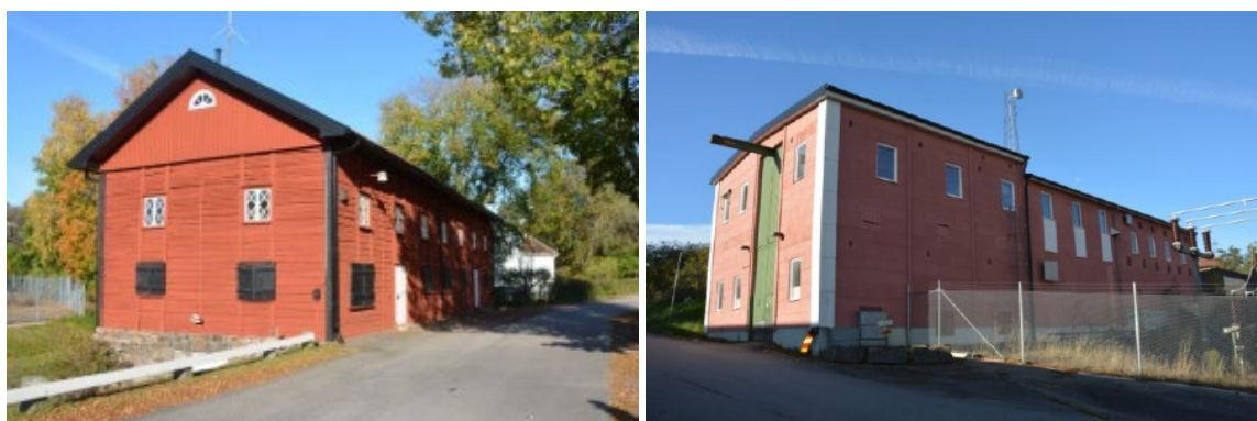
Bild 25. Magasinet till vänster och Bild 26 Jonventillaboratoriet till höger. På bilderna syns Kyrkbrovägen som ingår i planområdet.
