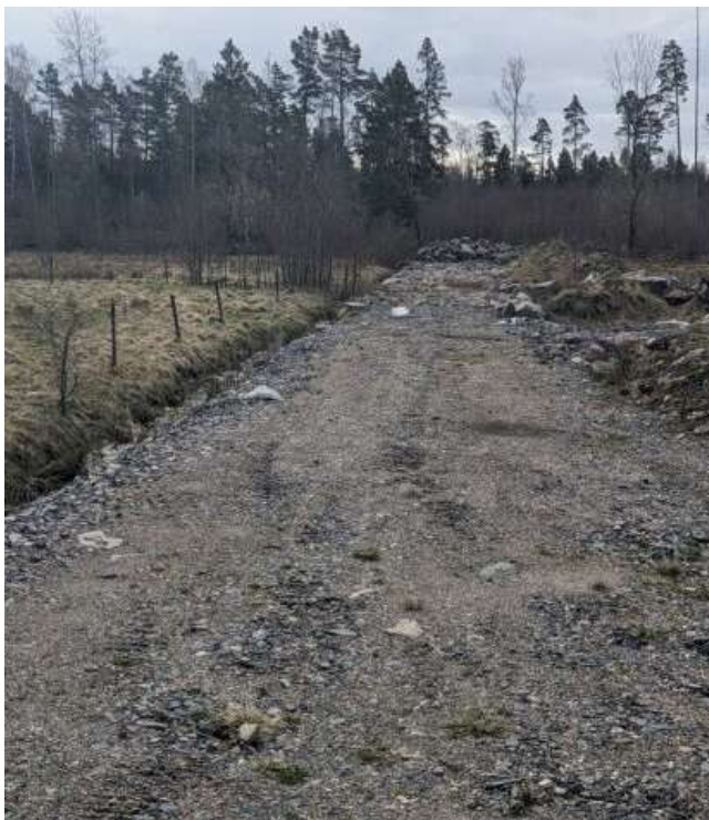
Figur 8 Bild G är tagen i riktning mot tilltänkt väggrändell, se orienteringsfigur ovan. Bilden visar grusväg med längs löpande dike på vänster sida samt två vinkelräta avskärande diken åt vänster, det första vid trädraden som delar åkern samt ett andra mellan åkern och skogspartiet i bakgrunden.
