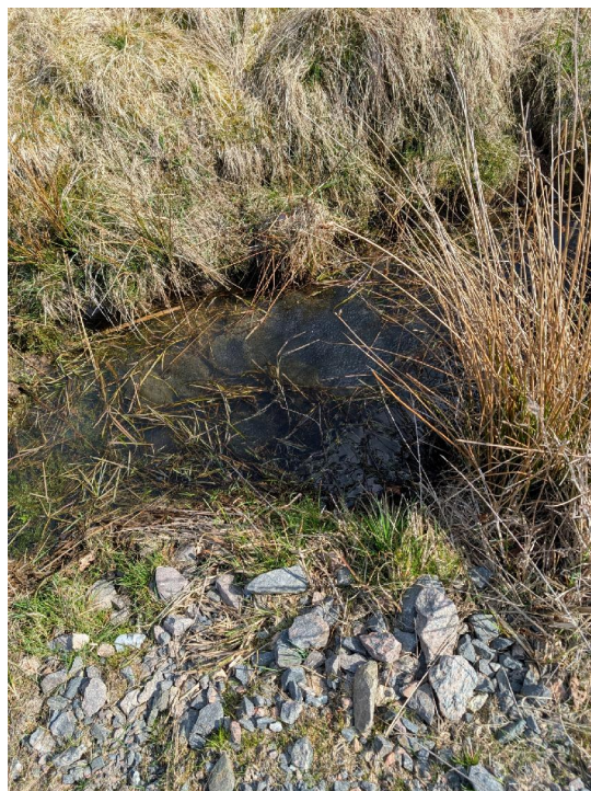
Figur 2. Dike 4 med den ”djuphåla” som finns i anslutning till den kulvert där dike 1 mynnar.
