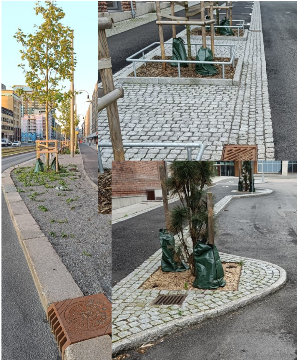
Figur 26. Bilderna visar exempel på hur växtbäddar och skelettjordar kan se ut vid gata med parkeringsfickor, GC-bana och flerbostadshus.
