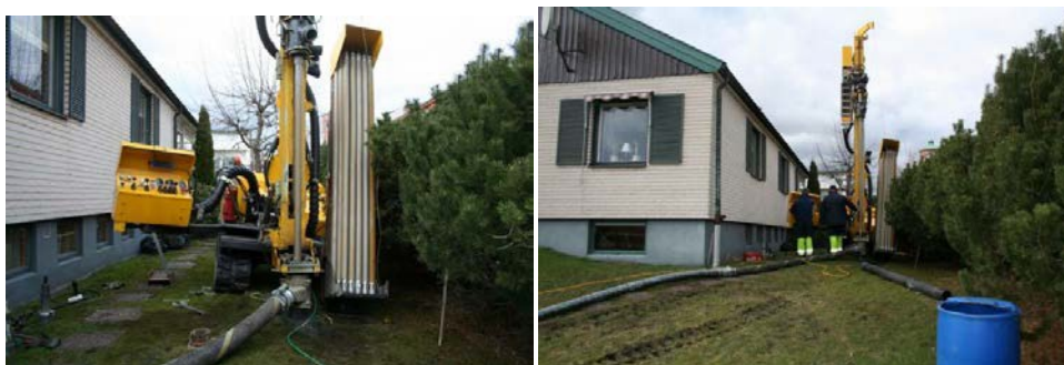
Figur 6 Borrning för bergvärme. (hämtat ur http://www.hus.se/galleri/galleri606.html )
