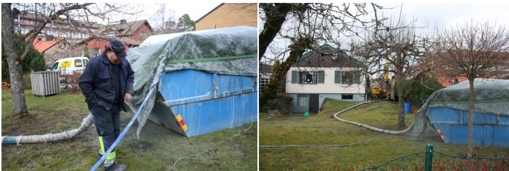
Figur 7 Foton som visar container för partikelavskiljning av uppumpat berggrundvatten (hämtat ur http://www.hus.se/galleri/galleri606.html ).
