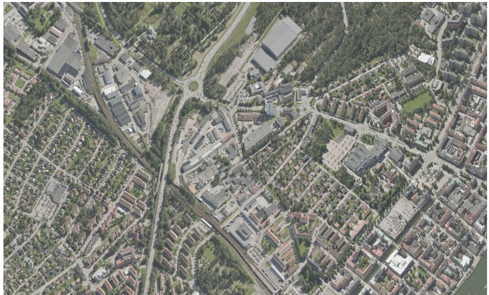
Utsnitt över delar av Trollhättans tätort med bebyggelse och infrastrukturleder.
