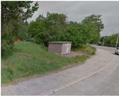
Transformator invid Nysättersvägen
