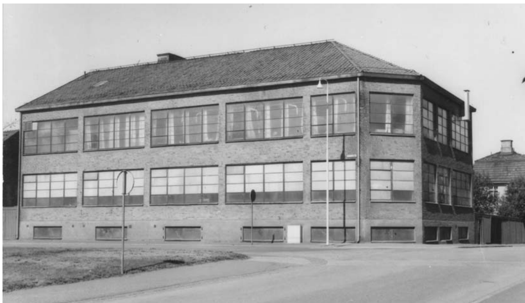
Grundbergs Mekaniska Verkstad, byggd 1942 efter det Nohabjärnvägen flyttats.
