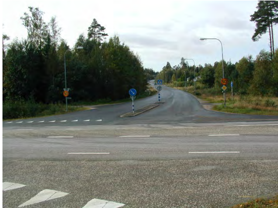
Nuvarande fyrvägs korsning vid Vänersborgsvägen
