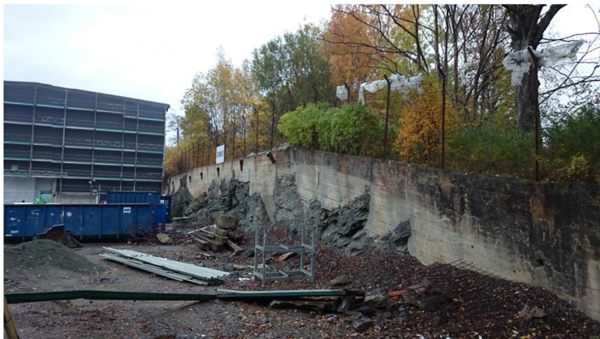
Bild 1. Mur ovan bergskärning i den östra delen av området.
