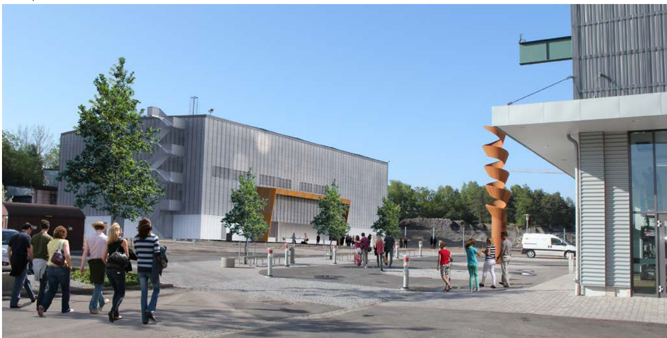
I områdets södra del omvandlas en av de befintliga byggnaderna till en sporthall som bl a innehåller badmintonbanor, den sk Innovatumhallen. Illustration: Contekton Arkitekter AB.
