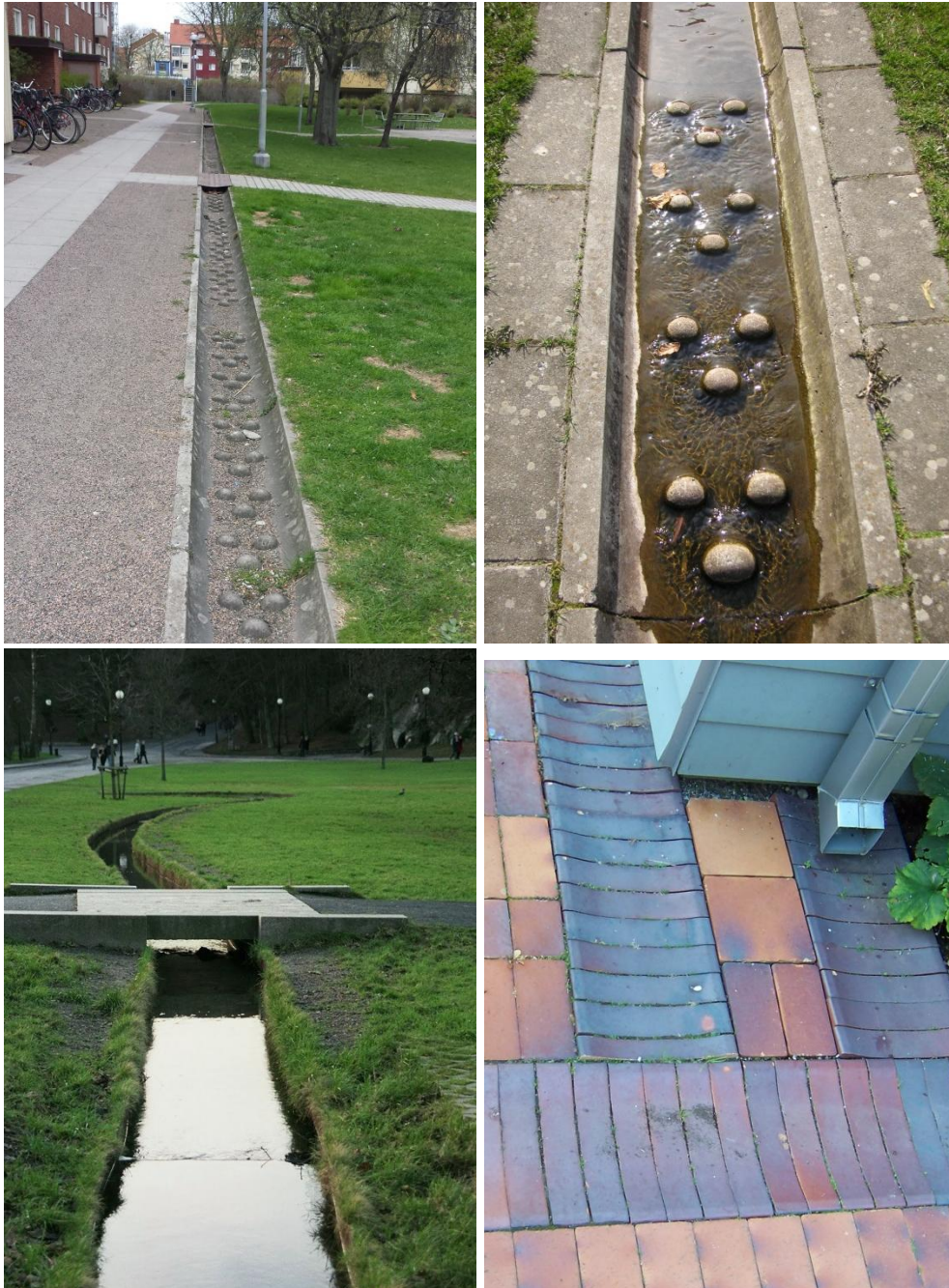
Figur 9. Inspirationsbilder för rännor mindre kanaler (foto: Ramböll).
