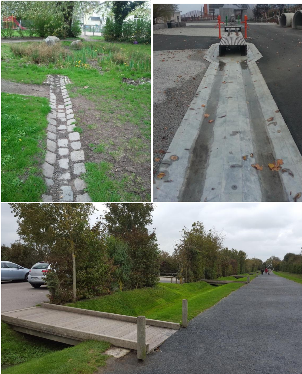
Figur 10. Inspirationsbilder för rännor mindre kanaler (foto: Ramböll).
