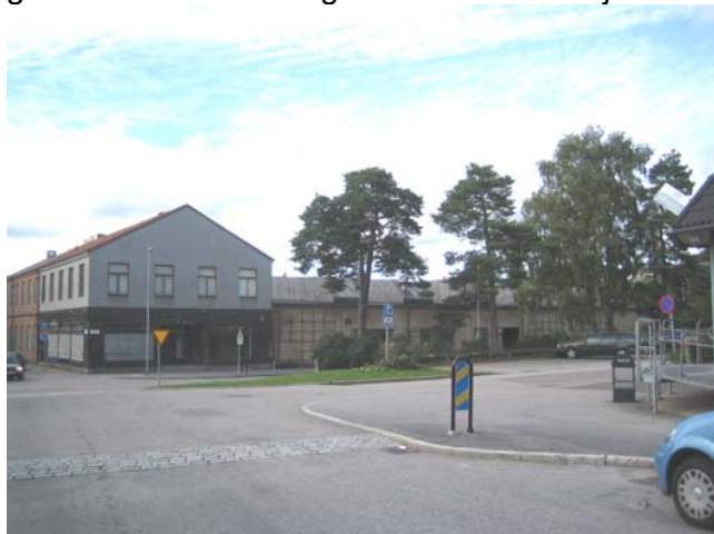
Befintlig industribyggnad rivs i samband med nybyggnad av bostäder
