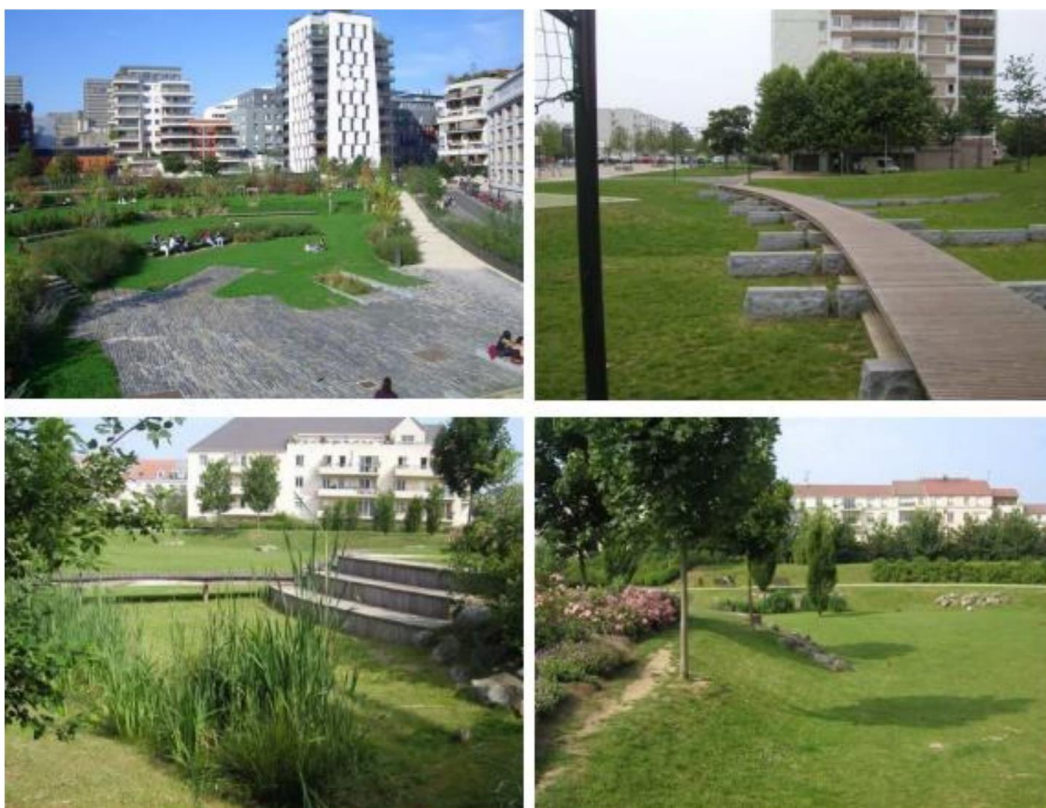
Figur 11 Parkytor som är anpassade för dagvatten
