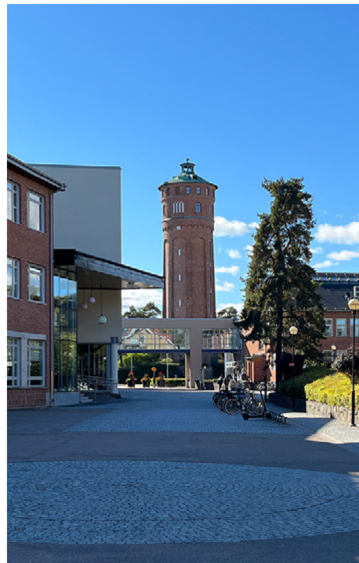
Figur 3: Högskolans nya entré till vänster, sedd från Djupebäcksgatan med gamla vattentornet i fonden.
