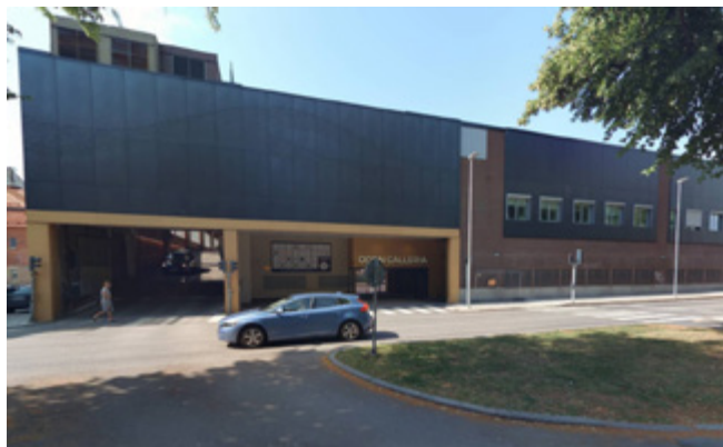
Figur 21: Odenhusets entré och fasad mot Drottninggatan.
