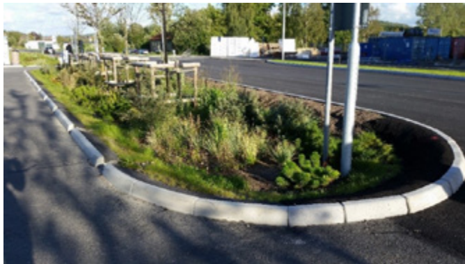
Figur 46: Exempel på regnbädd utmed gata. Källa: Dagvattenutredning Hults höjd, 2021, Norconsult
