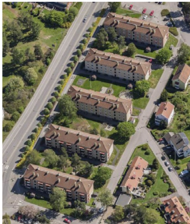
Figur 22: Flerbostadshus, i kvarteret Flottberget, söder om Gärdhemsvägen uppförda i slutet av 1940-talet.
