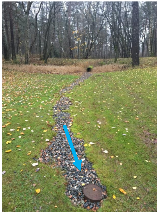
Figur 6: Ovan till vänster: Befintlig linjeavvattning i ramp för att förhindra ytavrinning mot Lasarettsvägen. Ovan till höger: Befintlig trumma som avvattnar lågpunkt utanför området. Längst ner: Befintlig dagvattendamm som ligger högre än omgivande mark.
