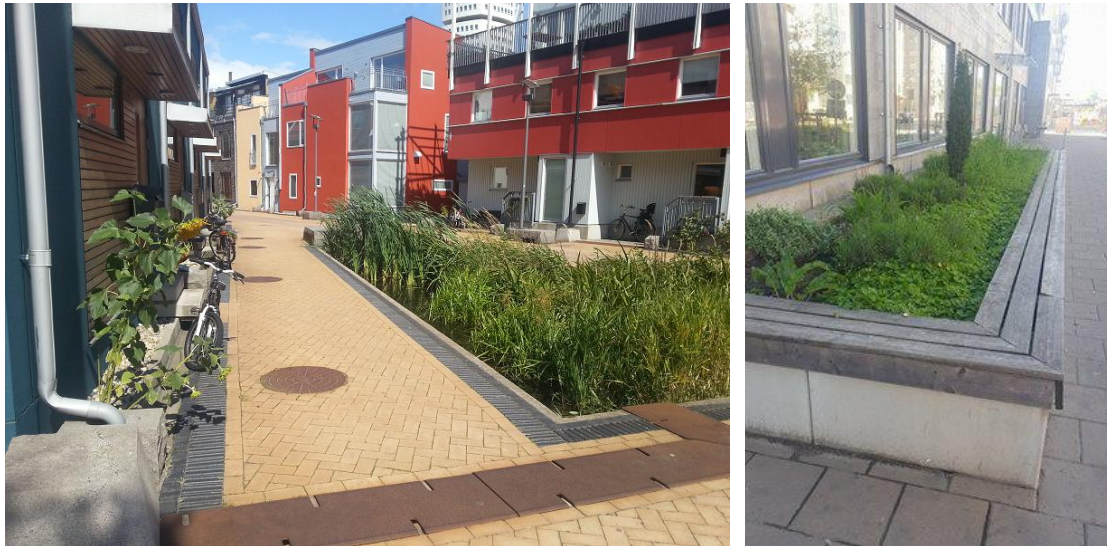
Figur 13: Till höger nedsänkt växtbädd/regnbädd på innergård, Bo01, Malmö. Till vänster upphöjd växtbädd, Hisingen, Göteborg. Foto: Ramboll
