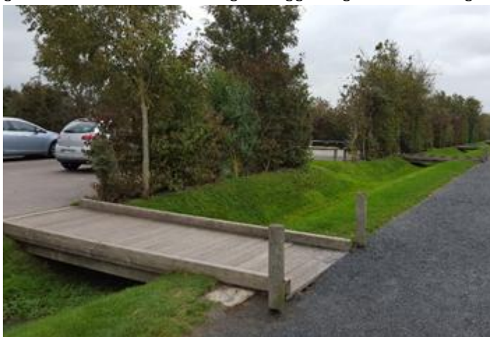
Figur 21: Exempel avskärande åtgärd i form av dike med broliknande övergång. Foto: Ramboll
