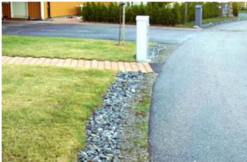
Figur 14: Exempel på makadamdiken i gräsyta och intill väg. Källa: Stockholm Vatten och Avfall.
