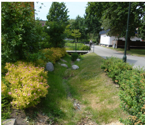
Figur 15 Exempel på grönt dike som kan anläggas längs med Flädervägen.
