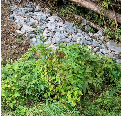
Figur 14 Diffust utlopp under mark av dagvatten, dels för rening men även för erosionsskydd och spridning av avrinnande vatten.
