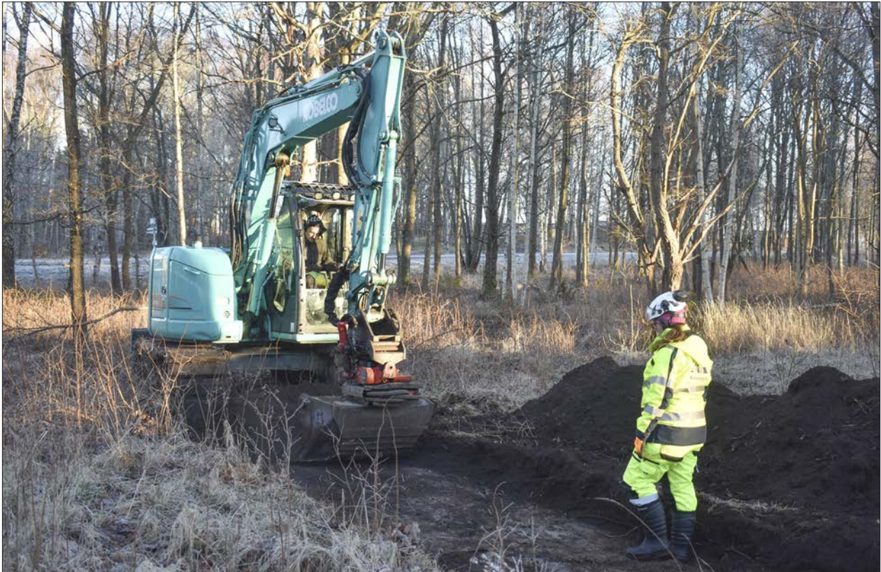
Figur 5. Sökschaktsgrävning pågår. Foto: Christina Rosén.
